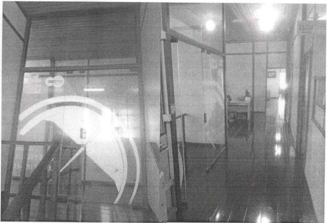
Figura 1 – Divisória de vidro a ser remanejada Figura 2 – Loca para reinstalação da divisória de vidro.
